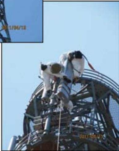
【4月13日】 高性能アンテナを設置 (いわき市内の基地局)
