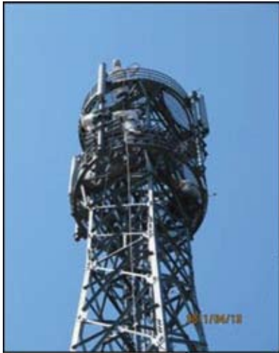
【4月13日】 高性能アンテナを設置 (いわき市内の基地局)
