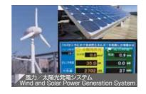
R&Dセンタでは自然エネルギーを有効活用するため、1号館屋上に太陽光発電(20kW及び50kW)と 風力発電システム(4kW)を設置。発電された電力を館内設備で有効活用することで環境に配慮した施 設運営に取り組んでいます。2号館屋上にも太陽光発電システム(3.3kW)を設置しています。
