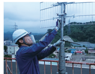
フェイスガード着用による設備復旧
