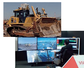
建設機械等の 遠隔操作
