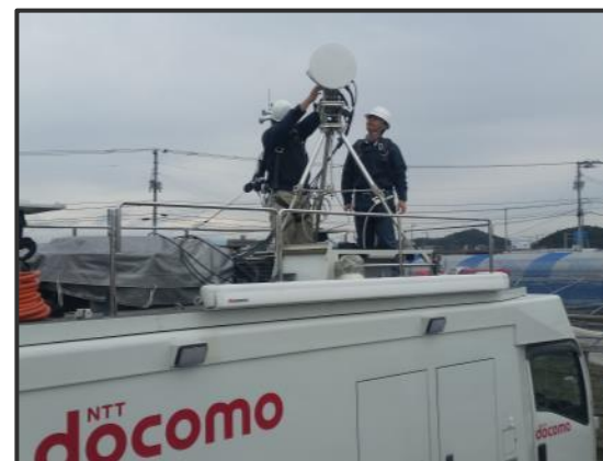
移動基地局車の設営
