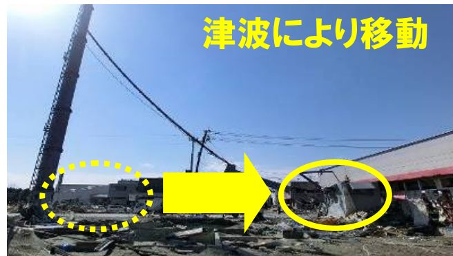
②基地局設備(宮城県 石巻緑町)
