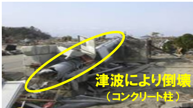
①基地局設備(宮城県 松島野蒜)
