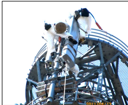
高性能アンテナを設置 (いわき市内の基地局)
