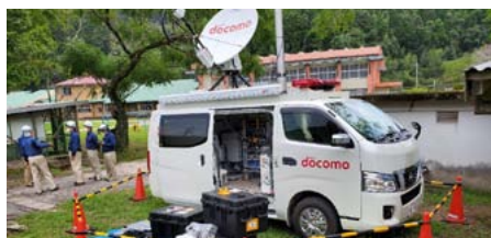
移動基地局車による令和2年台風第10号での実際のエリア救済の様子(鹿児島)
