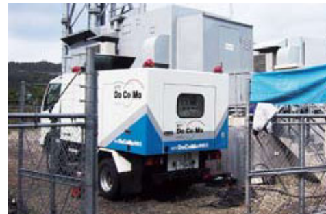
移動電源車による基地局の復旧作業風景
