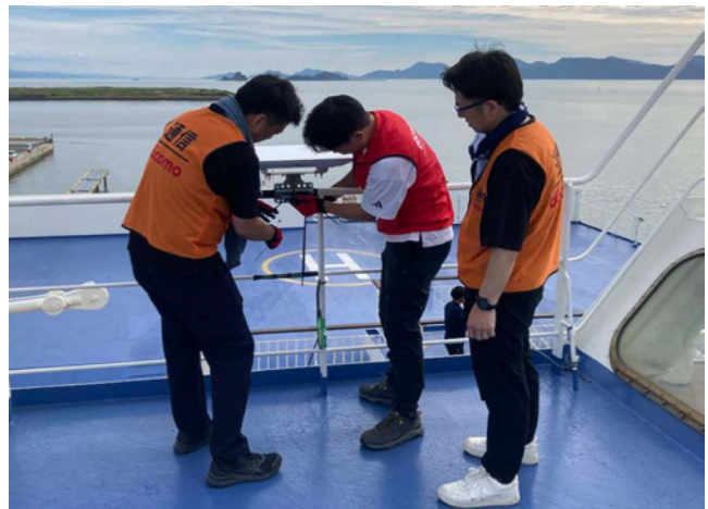
「はくおうⅡ」通信環境整備
