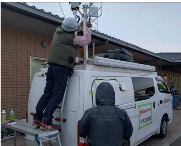
移動基地局車の設営
