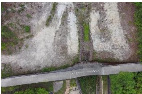
〈ドローンで撮影した砂防えん堤の映像〉
