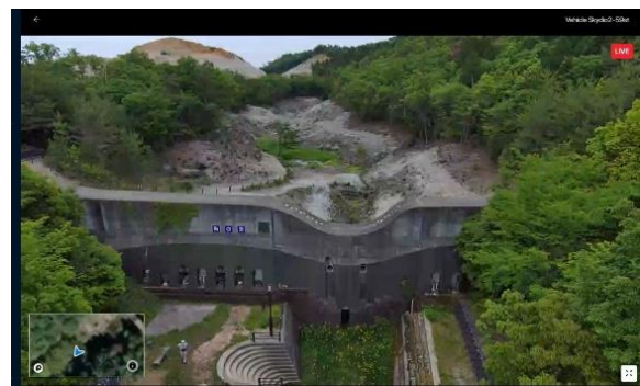
<市之倉おりべ砂防ダムからの映像伝送画面>
