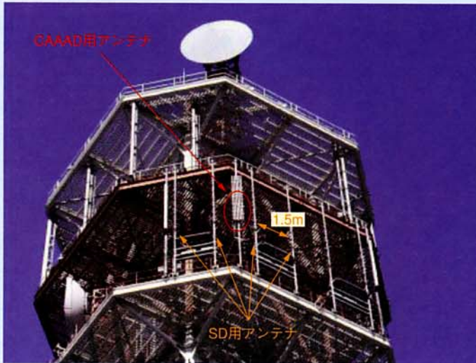
CAAAD : Coherent Adaptive Antenna Array Diversity (コヒーレント適応アンテナアレイダイバーシチ) SD : スペースダイバーシチ
