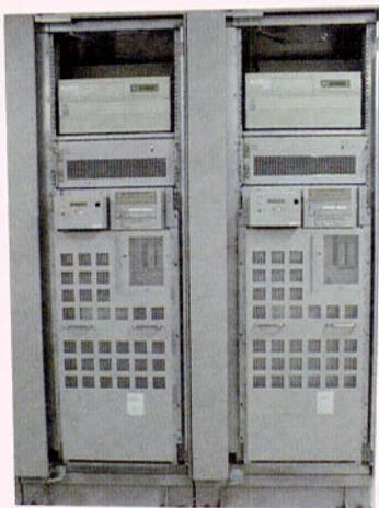
写真2 パケット関門中継処理装置
