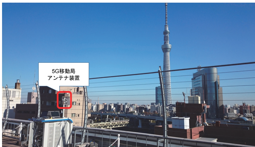
写真1(b) 5G移動局装置（東武鉄道浅草駅ビル屋上）
