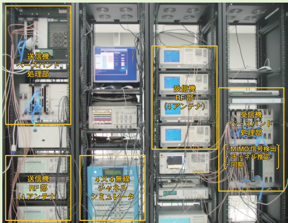
写真1 テストベッドの外観
