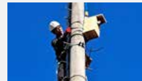
基地局への巣箱設置の様子
