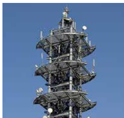
災害時に人口密集エリアの通信を確保する大ゾーン基地局
