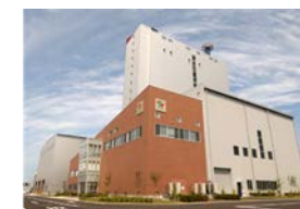
バイオマス発電所 (届出名称:向浜発電所)
