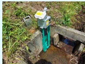
水門の開閉自動化や、水位状況を把握できるIoTセンサーを設置することで、水見回り回数の削減につながる
