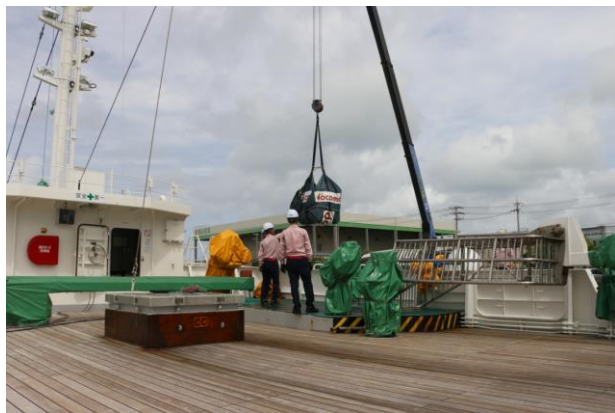
船舶クレーンによる搬入
