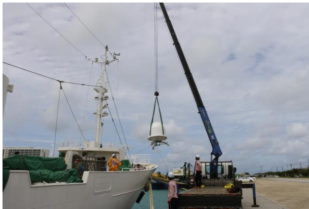
船舶クレーンによる搬入
