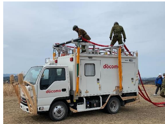
吊り具の取り付け確認
