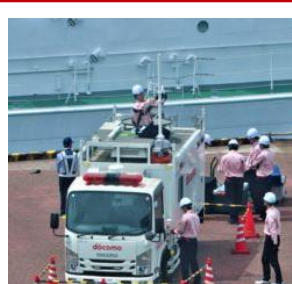
⑦移動基地局設営
