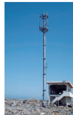
基地局設備の被害状況 (福島県南相馬市)
