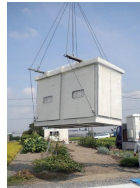
バッテリー収容箱の設置
