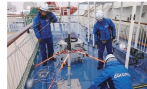
船上基地局設置訓練の様子
