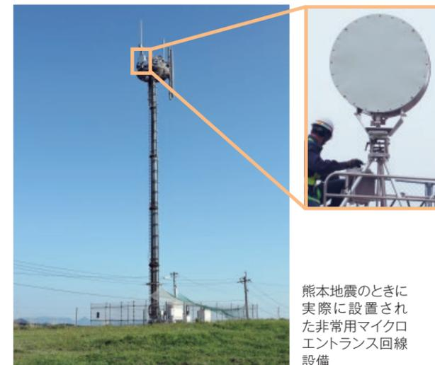
熊本地震のときに実際に設置された非常用マイクロエントランス回線設備
