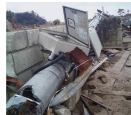
津波により倒壊した基地局設備
