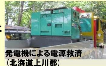
ドコモでは駆けつけ困難な離島・山間部の基地局に対して従来から予備電源の強化に取り組んでおり、停電が多発した台風18号では、その備えが功を奏した。(離島・山間部では、停電時に数日間の電源確保ができる基地局も多い)
