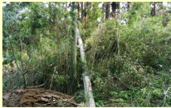
強風による倒木で倒れた電柱
