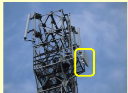
可搬ブースター (黄色枠内が周辺基地局向けアンテナ)
