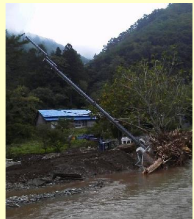
河川氾濫により、基地局設備(コンクリート柱)が被害を受けた。
