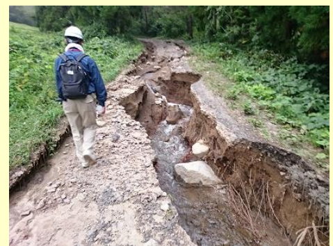
山上基地局までの道路が豪雨により割れたため、車両通行不可となった。サービス復旧の為、3時間かけ徒歩で機器を運搬。
